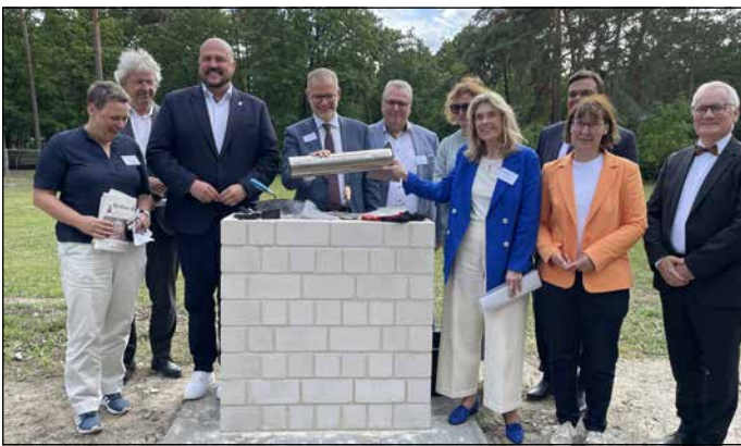
Der symbolische Höhepunkt: Die Grundsteinlegung
